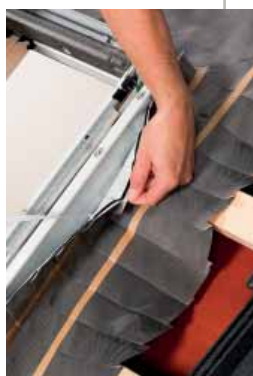
Alátétfólia vízelvezető csatornával
