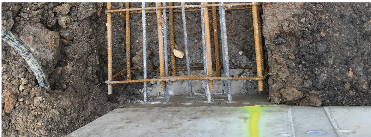
Utólagosan szerelt betonacél rögzítése betonlapba
