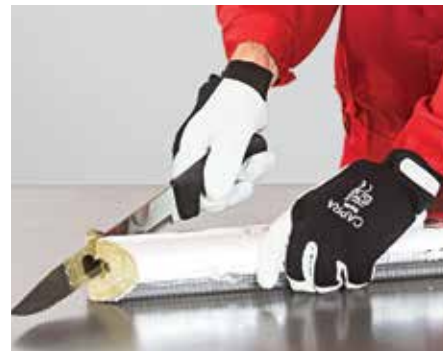
16. kép – 2x45°-os ék levágása a becsatlakozás helyén
