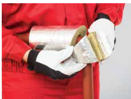
11. kép – Egy szegmens felhelyezése
