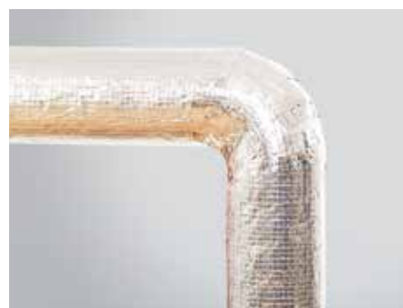
14. kép – Elkészült szigetelés PIPO ALS csőhéjjal
