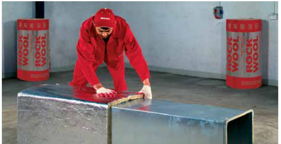
3. lépés – A szigetelés felragasztása
