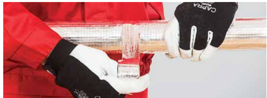
4. kép – Illesztések lezárása alumínium szalaggal
