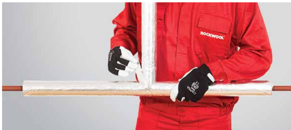
19. kép – Illesztések összeragasztása öntapadó alumínium szalaggal
