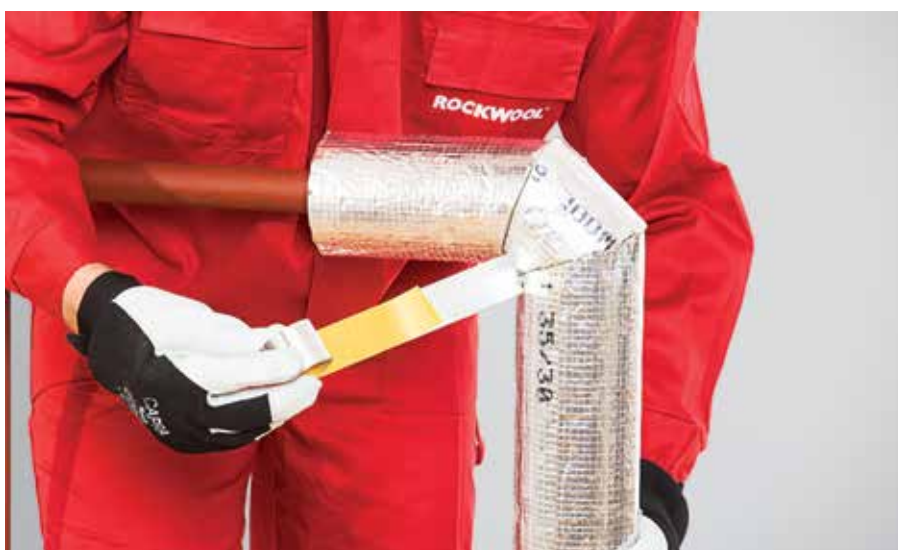
13. kép – Illesztések összeragasztása alumínium öntapadó szalaggal
