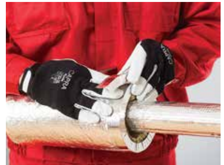
22. kép – A szigetelés lezárása alumínium szalaggal
