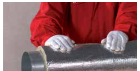
2. lépés – A szigetelés ráhajtása a csatornára
