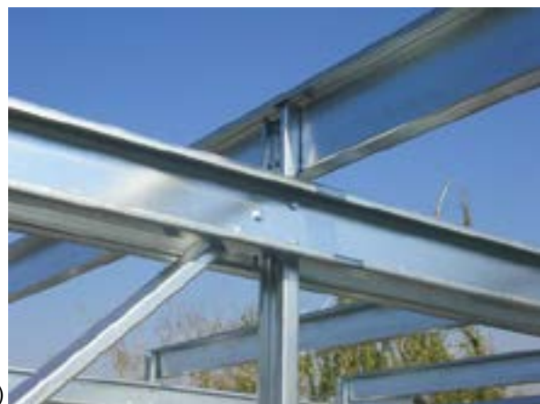
12. ábra. Megvalósult LindabTruss rácsostartós tetőszerkezet a) a tető komplett tartószerkezete; b) egymás után sorolt rácsostartók; c) egyedi háromtámaszú rácsostartó; d) előregyártott szerelési egységek deponálása beemeléshez; e) általános felső csomópont
