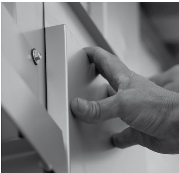
Lindab ECO falkazetta látszó rögzítéssel
