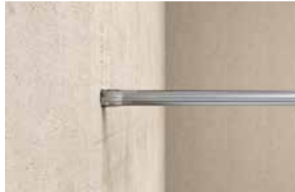
Üreges fúrás betonba
