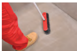
1 / Tisztítsa meg az aljzatot a portól és a szabad szemcsektől
