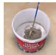
6 / Keverje össze a két komponenst.
