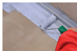
3 / Hordja fel a vízszigetelést a szükséges helyekre
