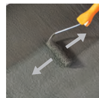
12 / Hordja fel a Folyékony vízszigetelés második rétegét.
