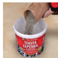
5 / Szórja bele a porszerű komponent a folyékonyba.
