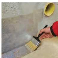
2 / Alapozza le az aljzatot, és egyenlítsse ki a nedvszívó képességét.
