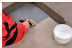
2 / Alapozza le az aljzatot, és egyenlítse ki a nedvszívó képességét
