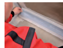
4 / Mérje le a megfelelő hosszúságú szalagot, és illessze a vízszigetelő bevonatba.
