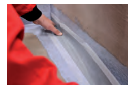
4 / Vágja le a megfelelő hosszúságú szalagot, és illessze a vízszigetelő bevonatba.
