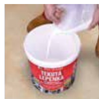
4 / Készítse elő a két komponensből a megfelelő mennyiséget a bevonathoz.
