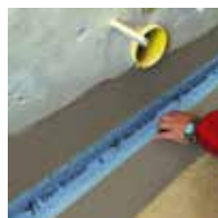
10 / Illessze bele az első bevonatrétegbe a Tömítőszalagokat és a Sarkötmitéseket.
