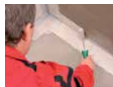
5 / Hordja fel a vízszigetelést a nagy kitettségi helvekre.
