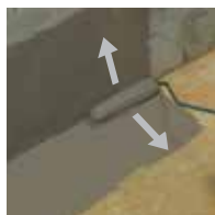
9 / Hordja fel a Folyékony vízszigetelés első rétegét.
