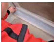
3 / Henger segítségével nyomja bele a Tömítő-szalagot a függőleges és vízszintes sarkakba.
