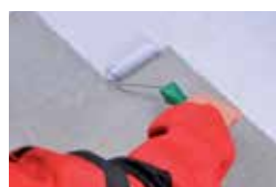
7 / Lehetőleg az első rétegre merőlegesen hordja fel a bevonóanyagot
